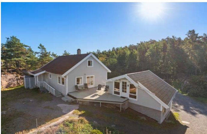
Adkomst til boligens 1. etasje.
