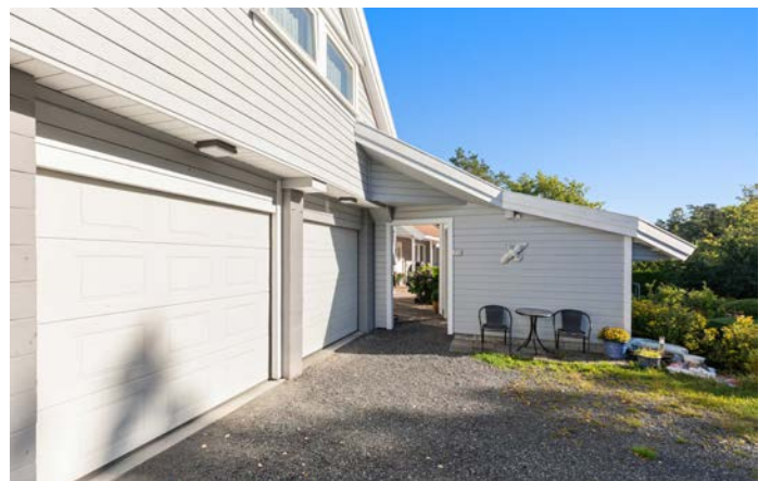
Adkomst til boligens underetasje.
