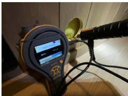
Hulltaking - Fuktmåling - Tørr konstruksjon i hulltakingsområdet.
