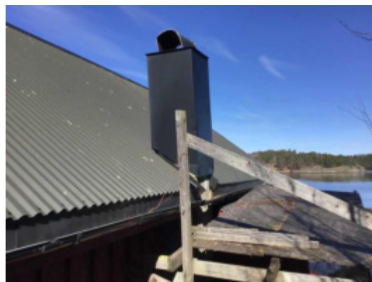
Pipegjennomføring i yttertaket.
