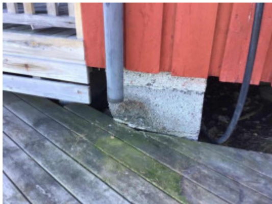
Avslutning nedløp - Vannsprut mot tilstøtende konstruksjoner.
