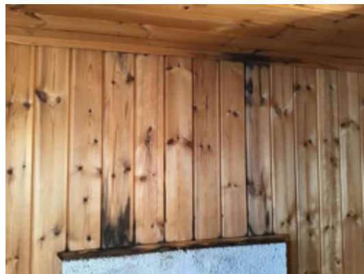
Overflater ved ildsted.
