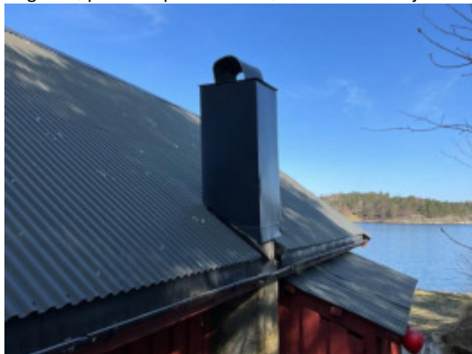
Avslutning nedløp - Vannsprut mot tilstøtende konstruksjoner.
