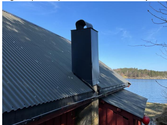
Avslutning nedløp - Vannsprut mot tilstøtende konstruksjoner.
