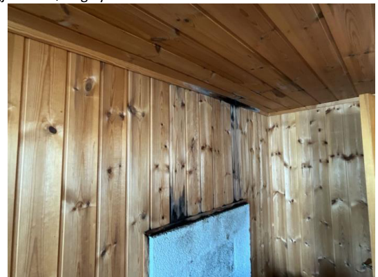
Pipegjennomføring i yttertaket.
