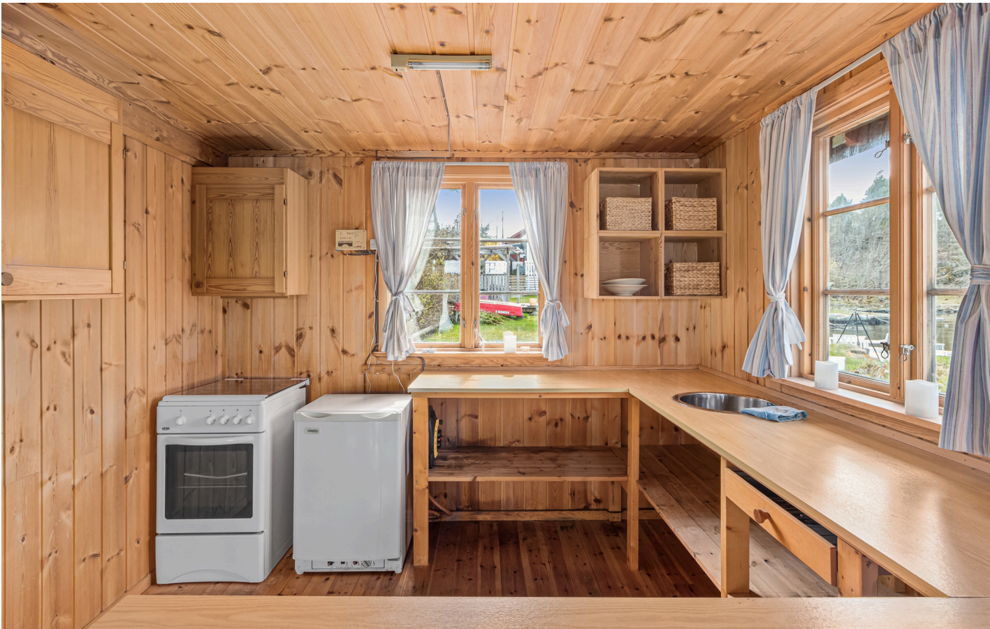
Enkel plassbygget kjøkkenbenk med laminert benkeplate
