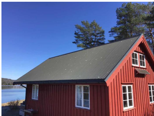
Taktekking - Stålplater.
