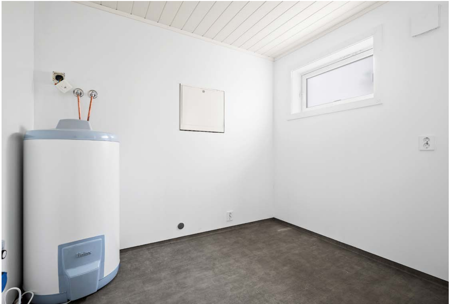
Vaskerom i underetasje
