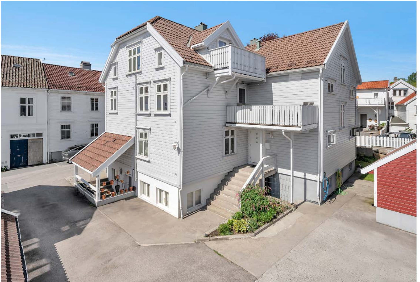
Felles inngangsparti på baksiden. Leiligheten vi har for salg benytter parkeringsplass nærmest bygget og har tilgang på EL-bil lader montert på ytterveggen.
