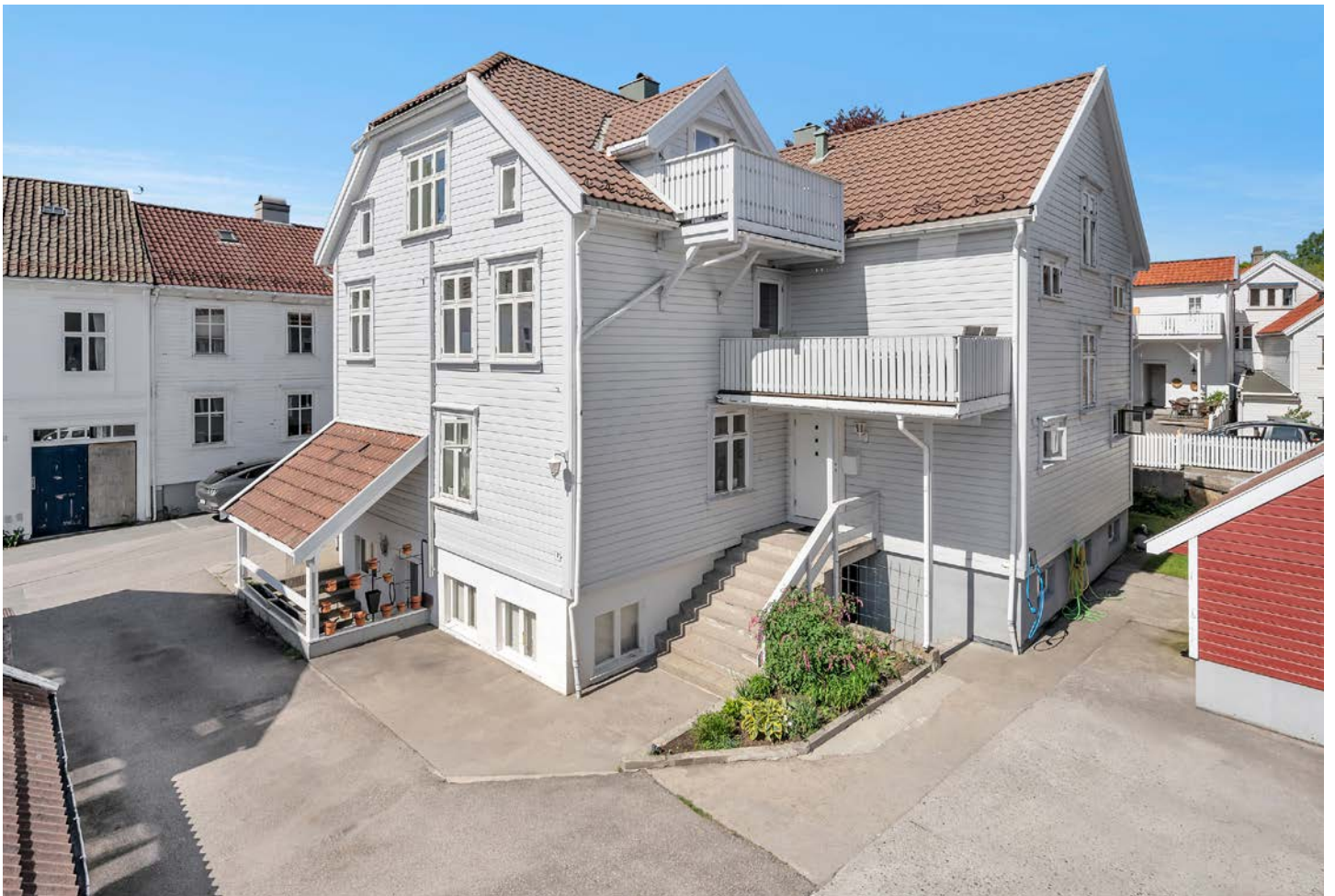
Felles inngangsparti på baksiden. Leiligheten vi har for salg benytter parkeringsplass nærmest bygget og har tilgang på EL-bil lader montert på ytterveggen.
