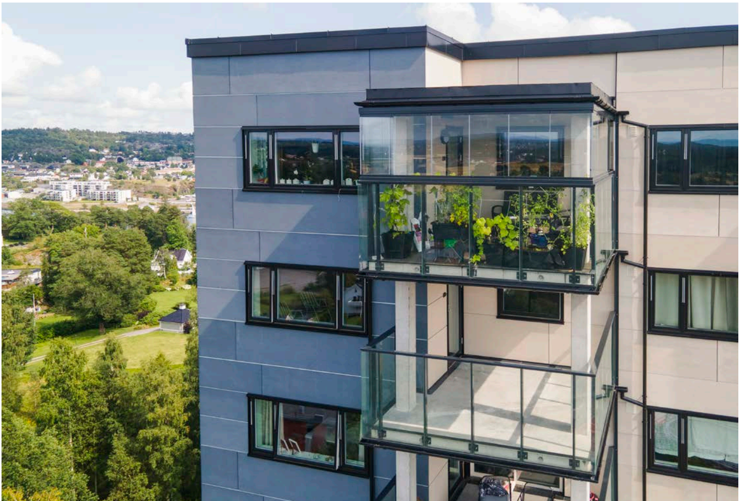
Fasader er nylig etterisolert, rehabilitert, samt med utvidede balkonger
