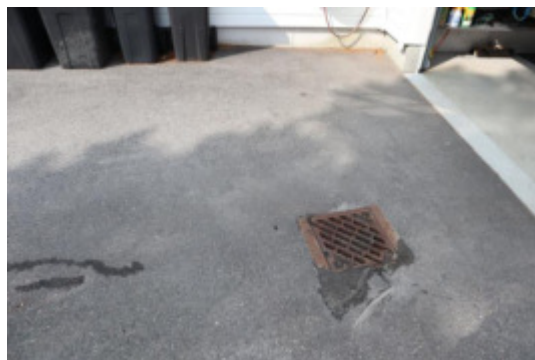
Rist og varmekabel i bakken foran garasjen.
