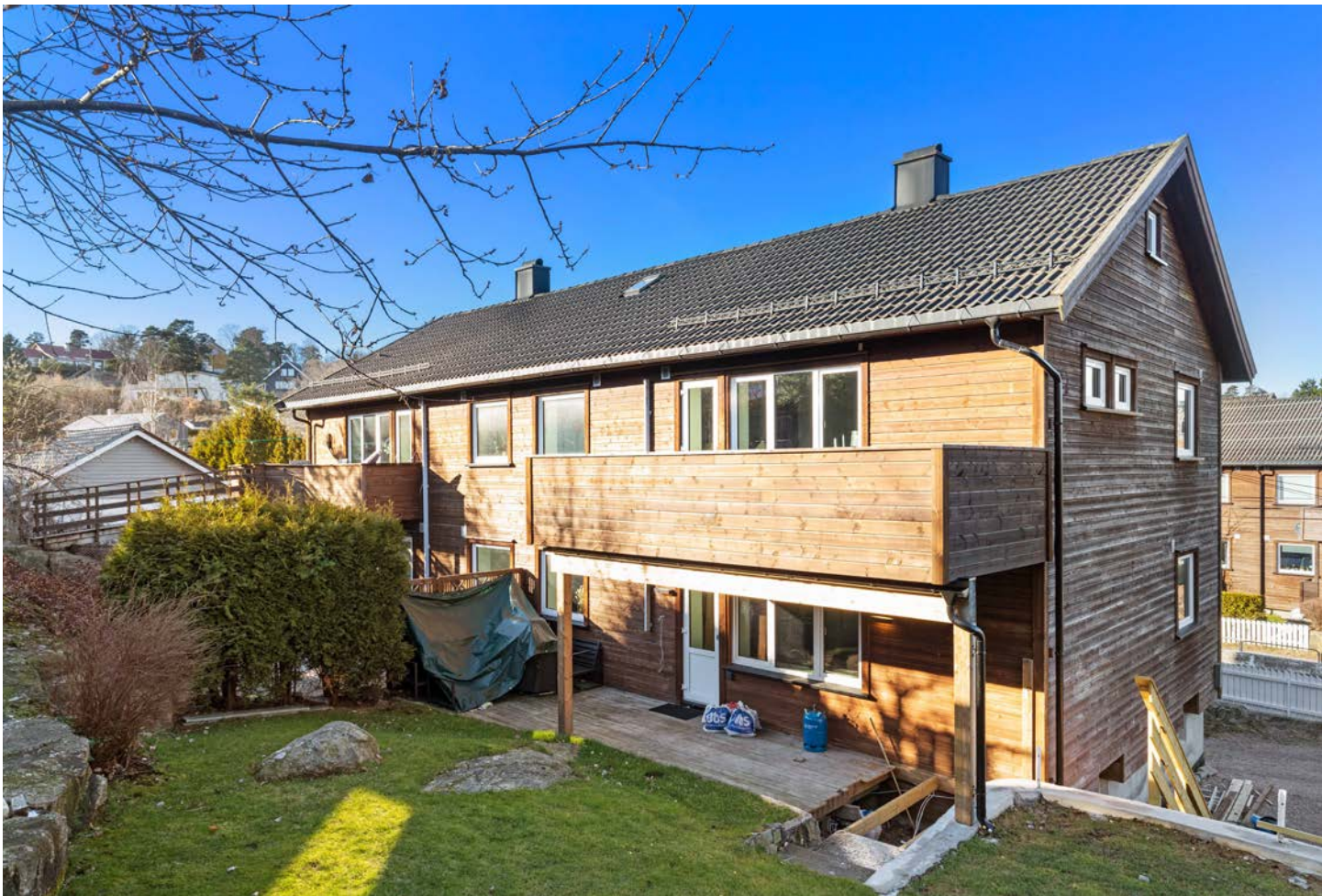
Leilighet i 2.etg. med innredet loft (ikke godkjent til varig opphold)
