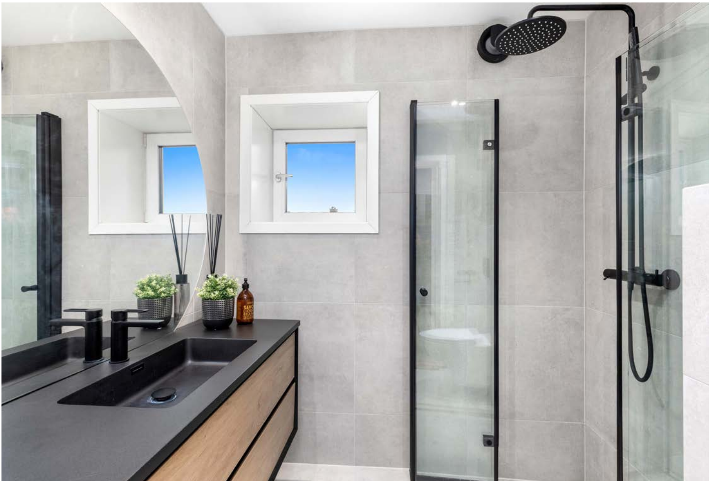
Nyere flislagt bad med varmekabler i gulv
