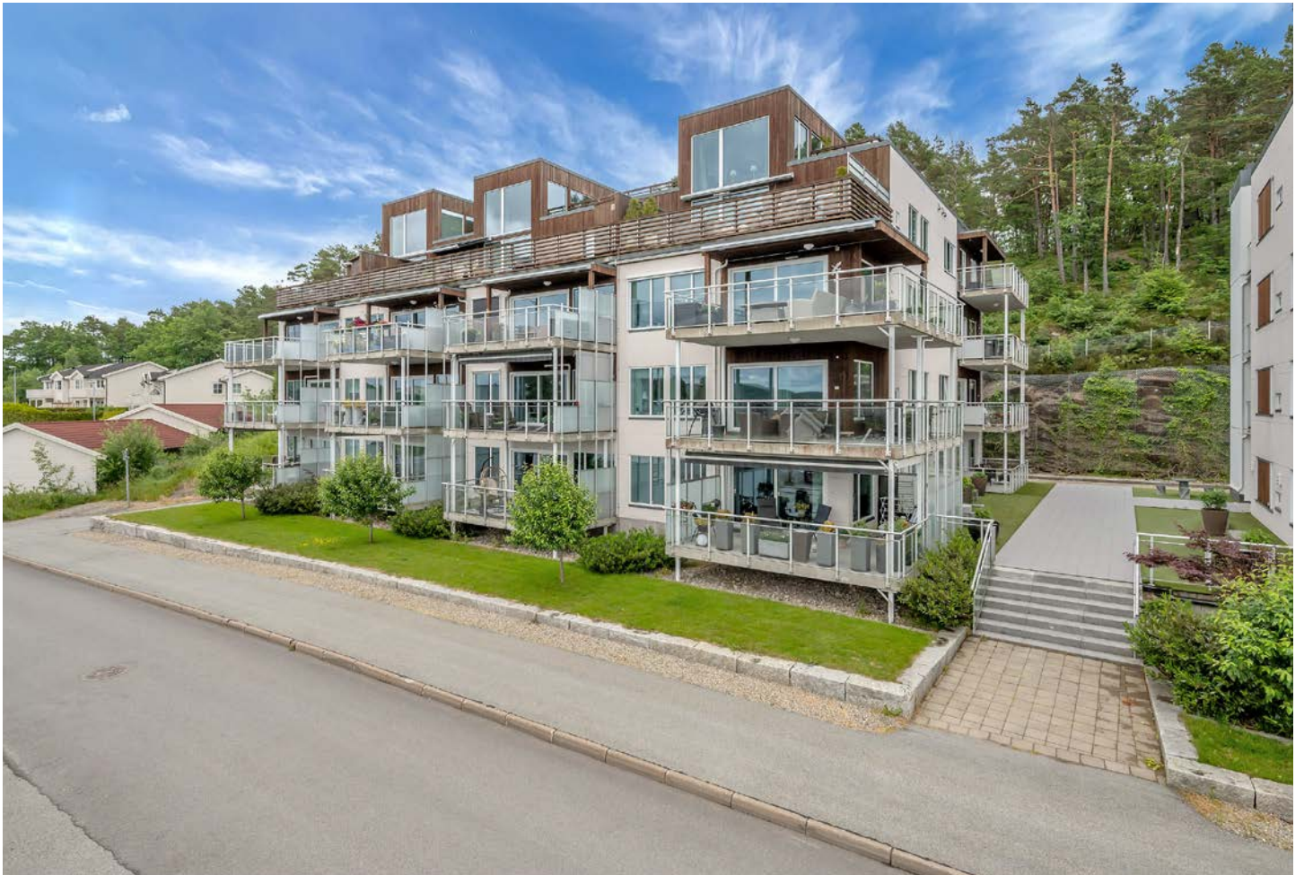
Sameiet har en pen fasade og opparbeidede uteområder.
