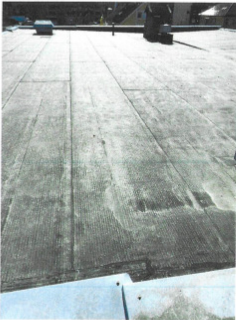
Taktekking, Derbigum, på del av bygg mot syd. Taktekking, folie, med stein oppå, mot nord.
