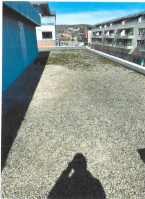
Taktekking, Derbigum, på del av bygg mot syd. Taktekking, folie, med stein oppå, mot nord.
