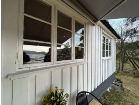
Vinduer, nylig kittet og ettersett.
