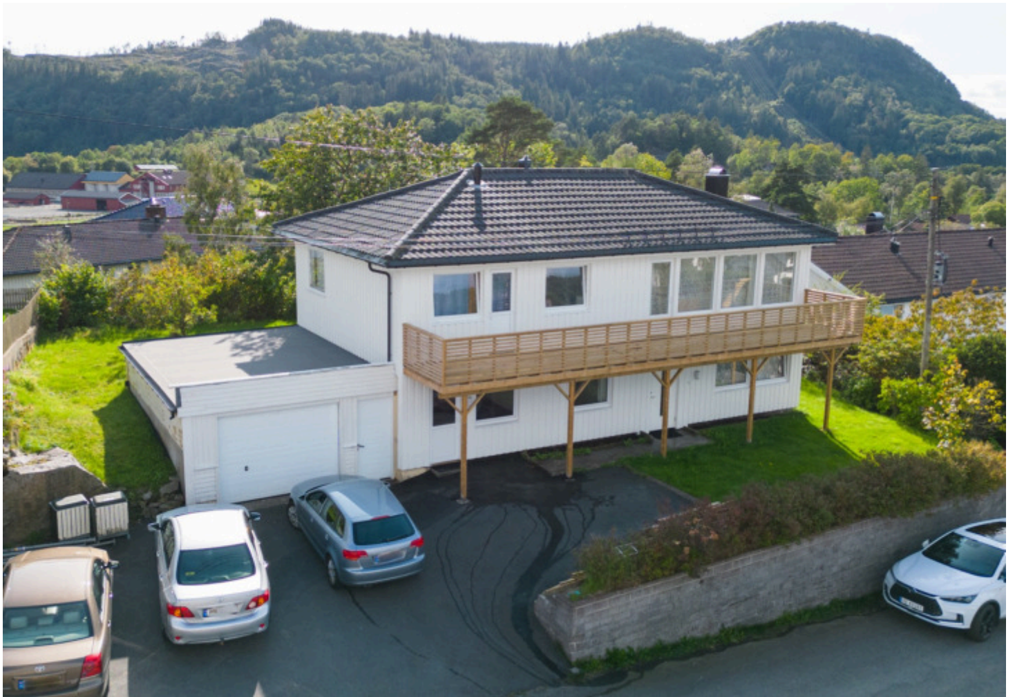
Asfaltert foran garasje og uteområde ved inngang.
