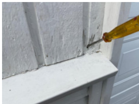
Spredte råteskader
