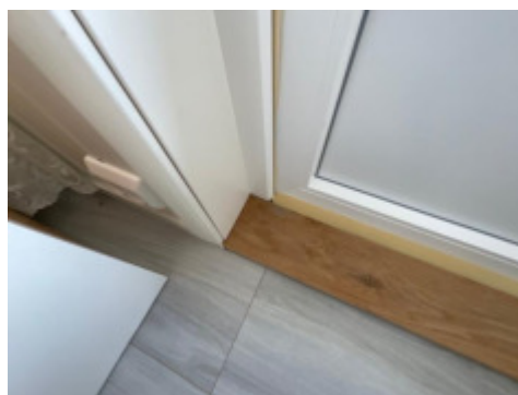
Skumgummi er lagt mellom dør og karm for å stoppe trekk
