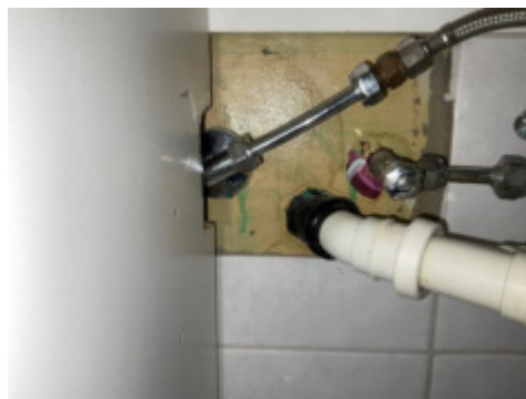
Rørgjennomføring i vegg under servant
