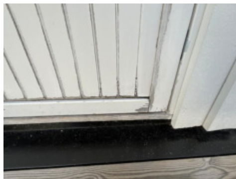
Balkongdør på sørsiden
