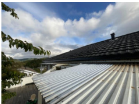
Tak over veranda
