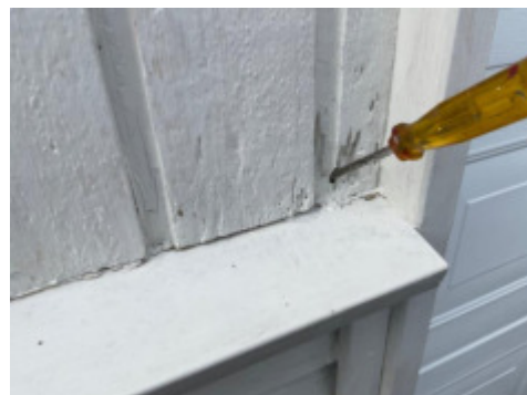
Spredte råteskader
