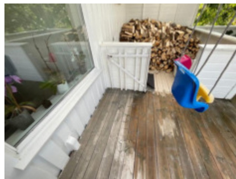
Kort avstand mellom terrassebord og kledning
