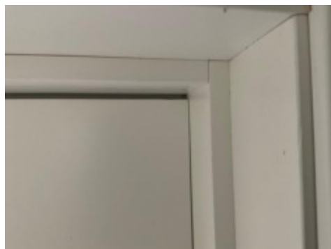
Utettheter mellom karm og dør
