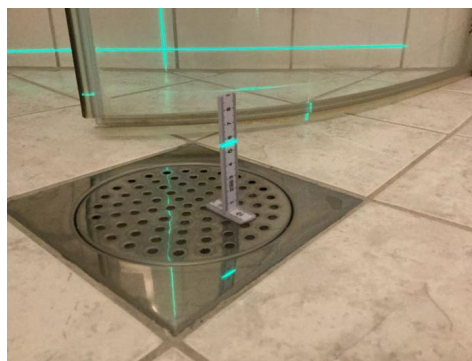
Måling ved sluk
