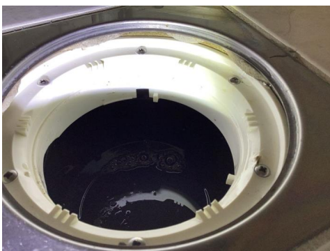
Synlig membran / mansjett under klemring
