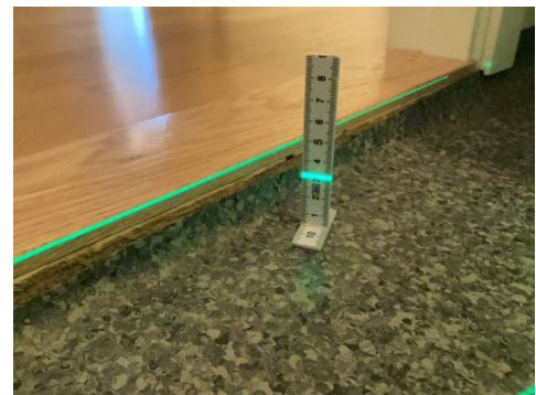
Måling ved terskel
