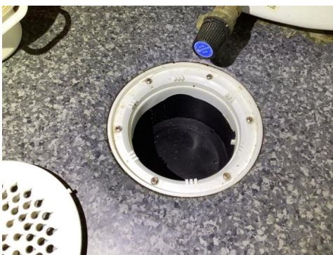
Synlig membran under klemring.
