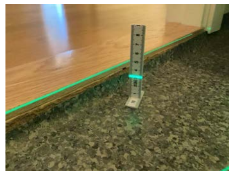
Måling ved terskel
