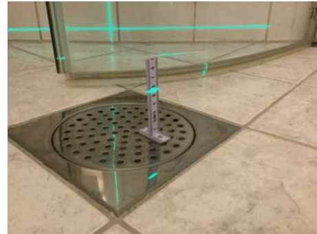
Måling ved sluk
