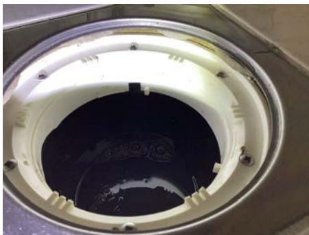
Synlig membran / mansjett under klemring
