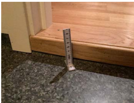
Måling ved terskel
