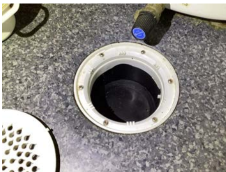
Synlig membran under klemring.
