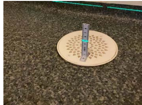
Måling ved sluk
