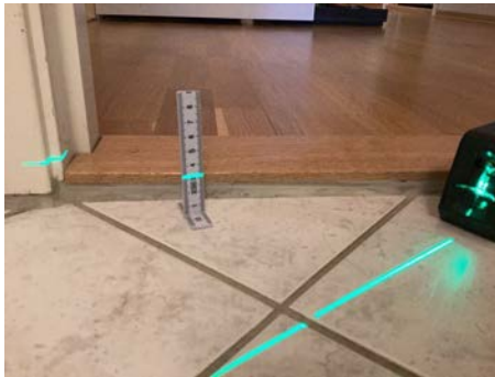
Måling ved terskel
