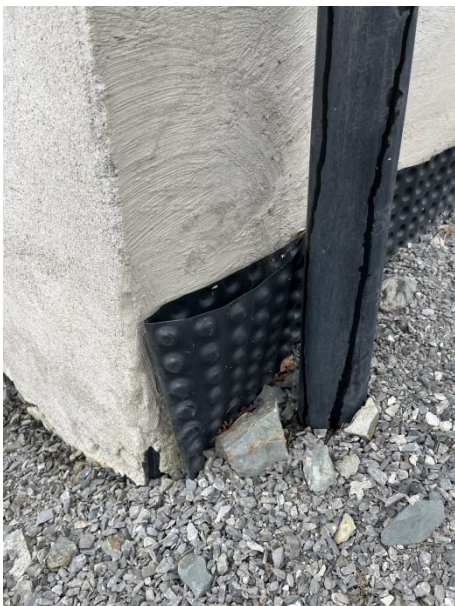
Avskaling av overflatepuss. Det observeres "Gudron" som tettesikt bak pussen.
