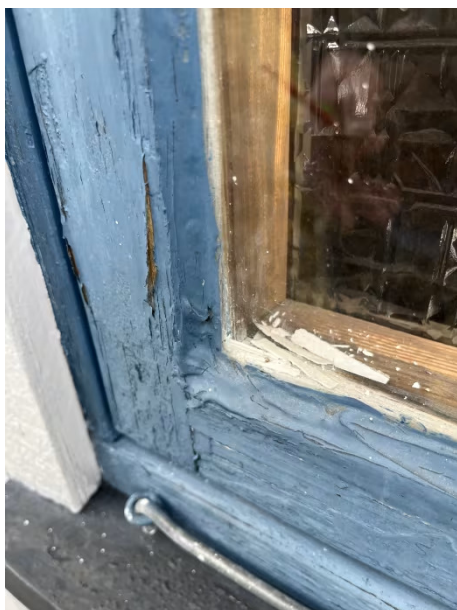
Vinduene i trappegang.
