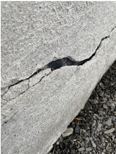
Avskaling av overflatepuss. Det observeres "Gudron" som tettesikt bak pussen.
