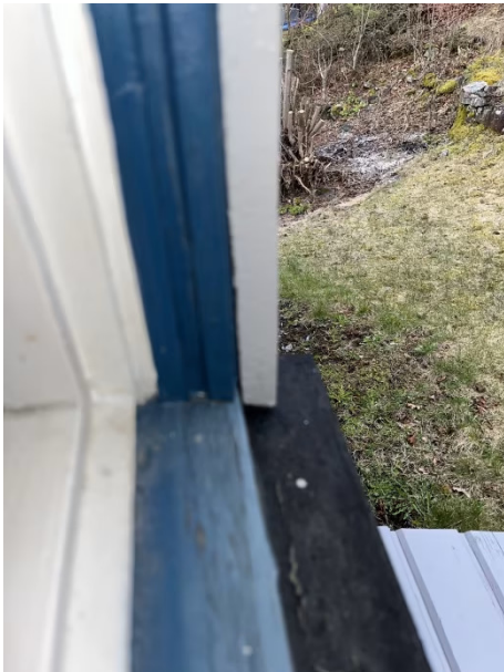
Karmene på vinduene, spesielt mot vest og syd, har oppbrukt sin levetid.
