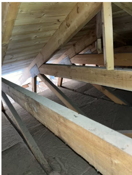
Prefabrikkerte W-takstoler. Lufting i gesims.
