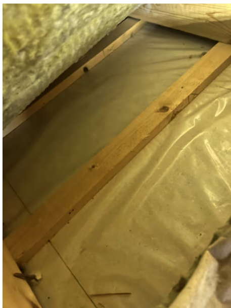
Diffusjonssperre mellom varm og kald side er påvist.
