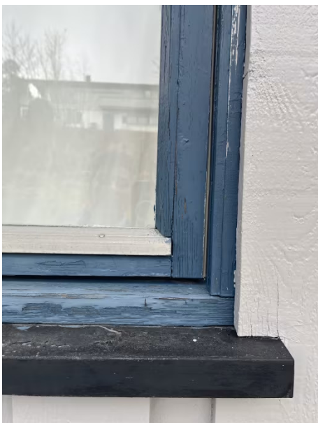
Karmene på vinduene, spesielt mot vest og syd, har oppbrukt sin levetid.
