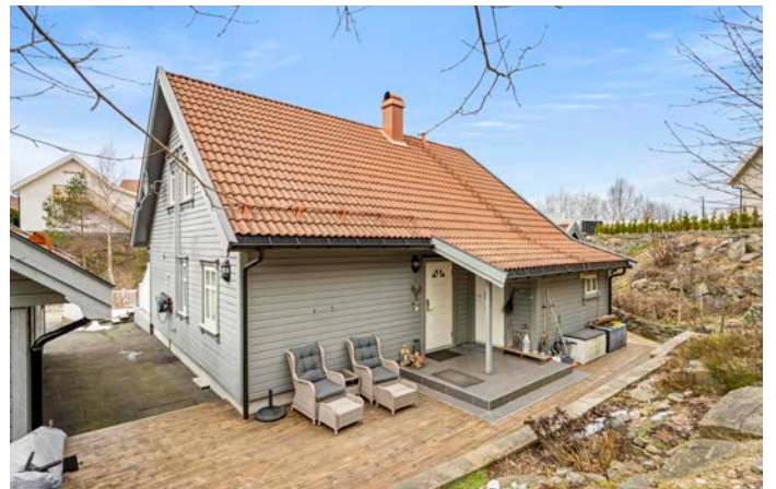
Stor terrasse ved inngangspartiet
