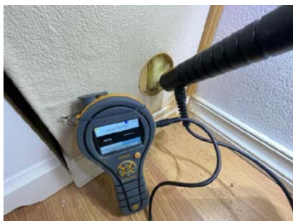
Hulltaking - Fuktmåling - Tørr konstruksjon i hulltakingsområdet.
