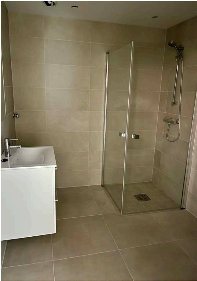
Bad under bygging
