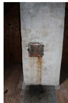
Mursteinspipe på loftet med feieluke.
