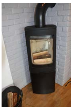
Peisovn i 2.etg. Den er ikke koblet til pipen.
