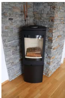
Peisovn i 2.etg. Den er ikke koblet til pipen.
