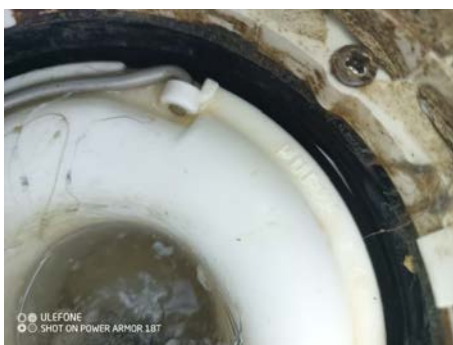
Ingen synlig membran i sluken under klemring
