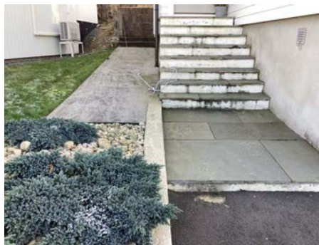
Fall på terreng ved siden av bolig
