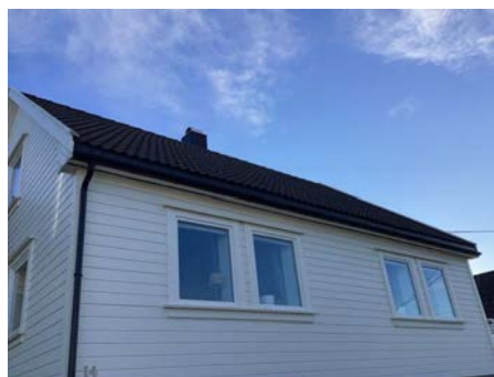
Taket har ikke snøfangere
