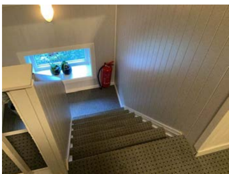
Trapp har ikke håndløper på vegg
