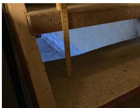
Åpninger er større enn dagens krav
