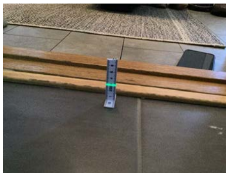
Måling ved terskel
