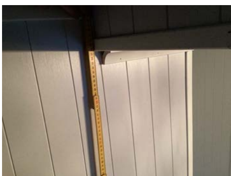
Trapp har ikke håndløper på vegg
