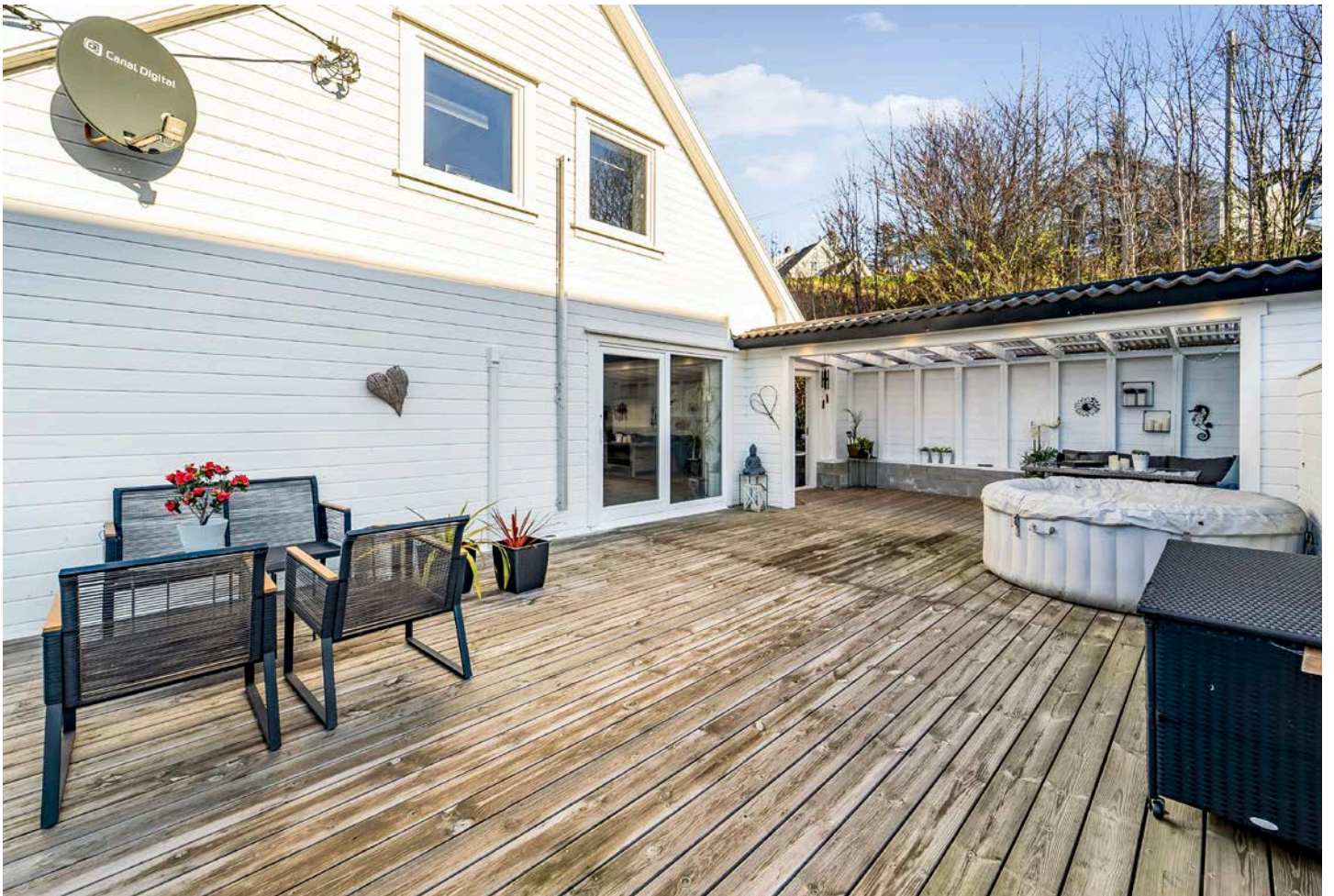
Stor terrasse med overbygg. (ikke byggemeldt)
