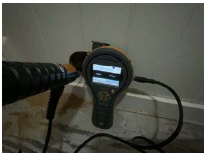
Hulltaking - Fuktmåling - Tørr konstruksjon i hulltakingsområdet.
