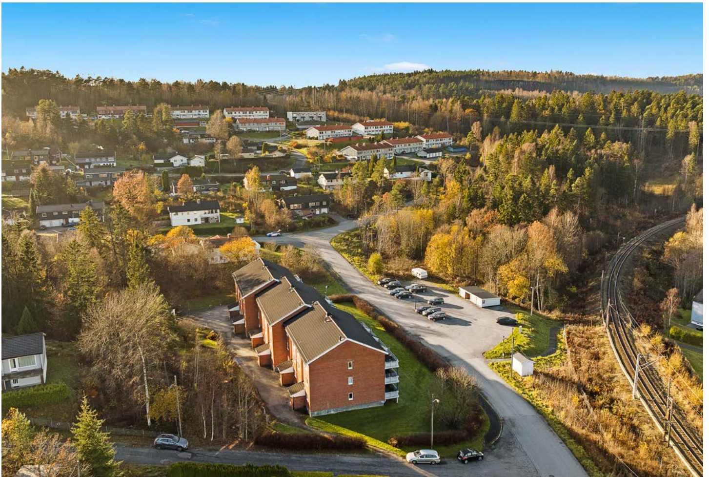
Området består hovedsakelig av enebolig- og rekkehusbebyggelse, samt noe leiligheter som i Orrevegen
