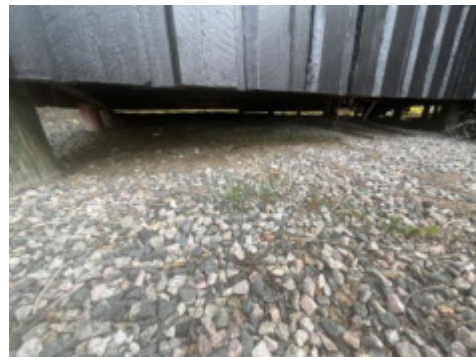
Pilarer under tilbygg.
