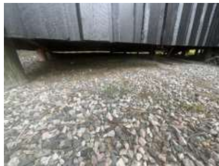
Pilarer under tilbygg.
