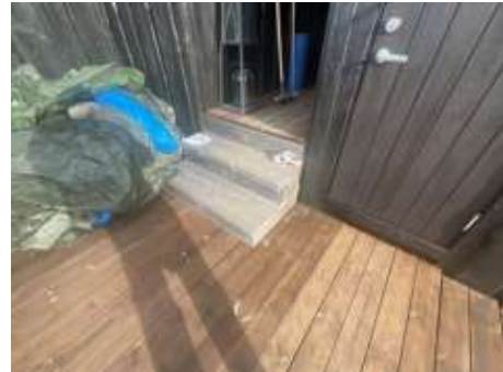
Trinn i tre mot inngangsparti.
