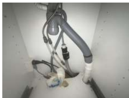
Avløpsrør i plast.
