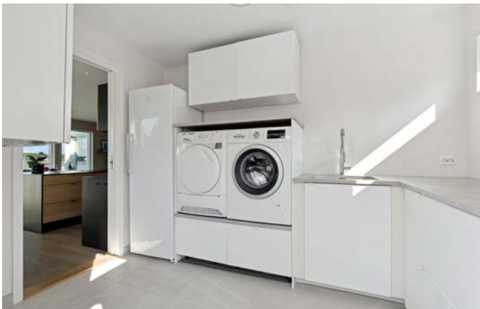
Grovkjøkken/ teknisk rom. Ikke godkjent vaskerom pga krav til sluk
