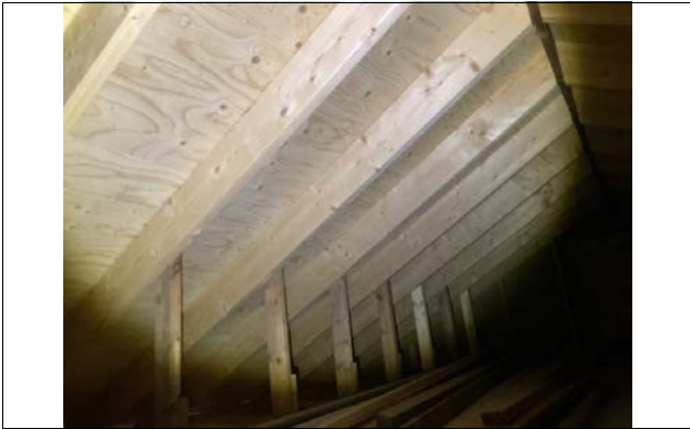
Undertak garasje. Ingen synlige lekkasjer registrert
