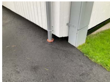
Taknedløp ledes til overvannsrør
