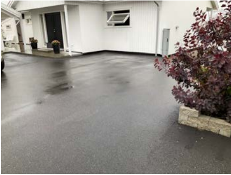
Gårdsplass med asfalt og støpte flater.
