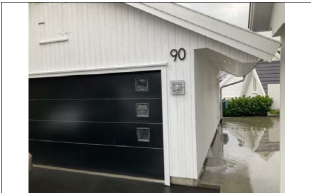
Leddet port og yttervegger med trepanel/kledning
