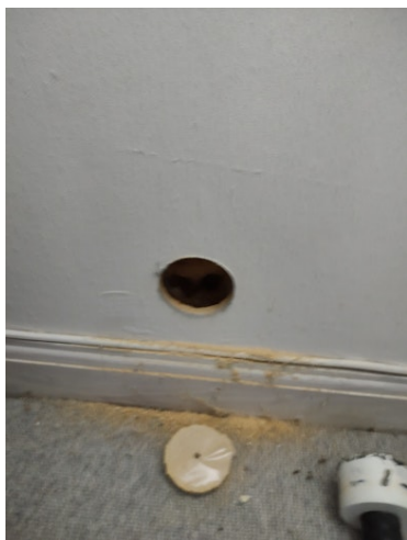
Hulltaking utført på utforet vegg.
