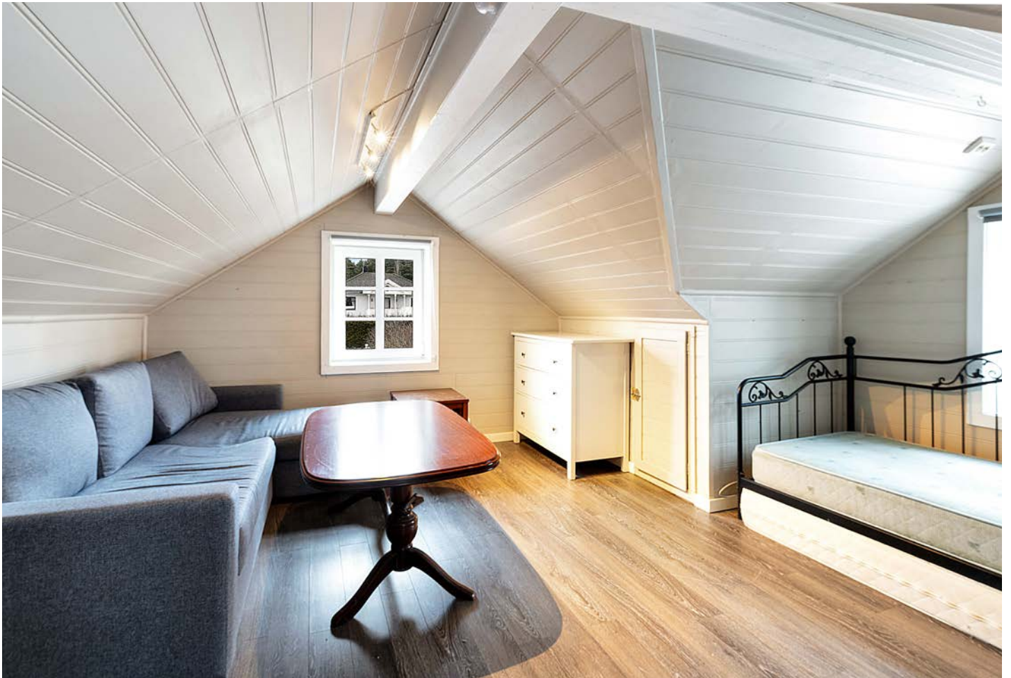
Innredet loft på garasje ikke godkjent for varig opphold.
