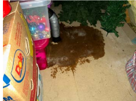
Tegn til lekkasje på loft.
