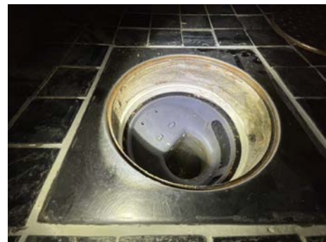
Klemringen er løs og det er ikke smurt membran på mansjett.
