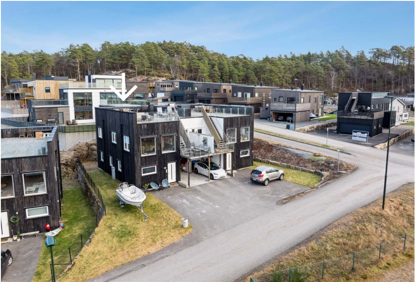
Flott familiebolig i Bårågerveien 25 del av vertikaldelt 2-mannsbolig på Ausviga
