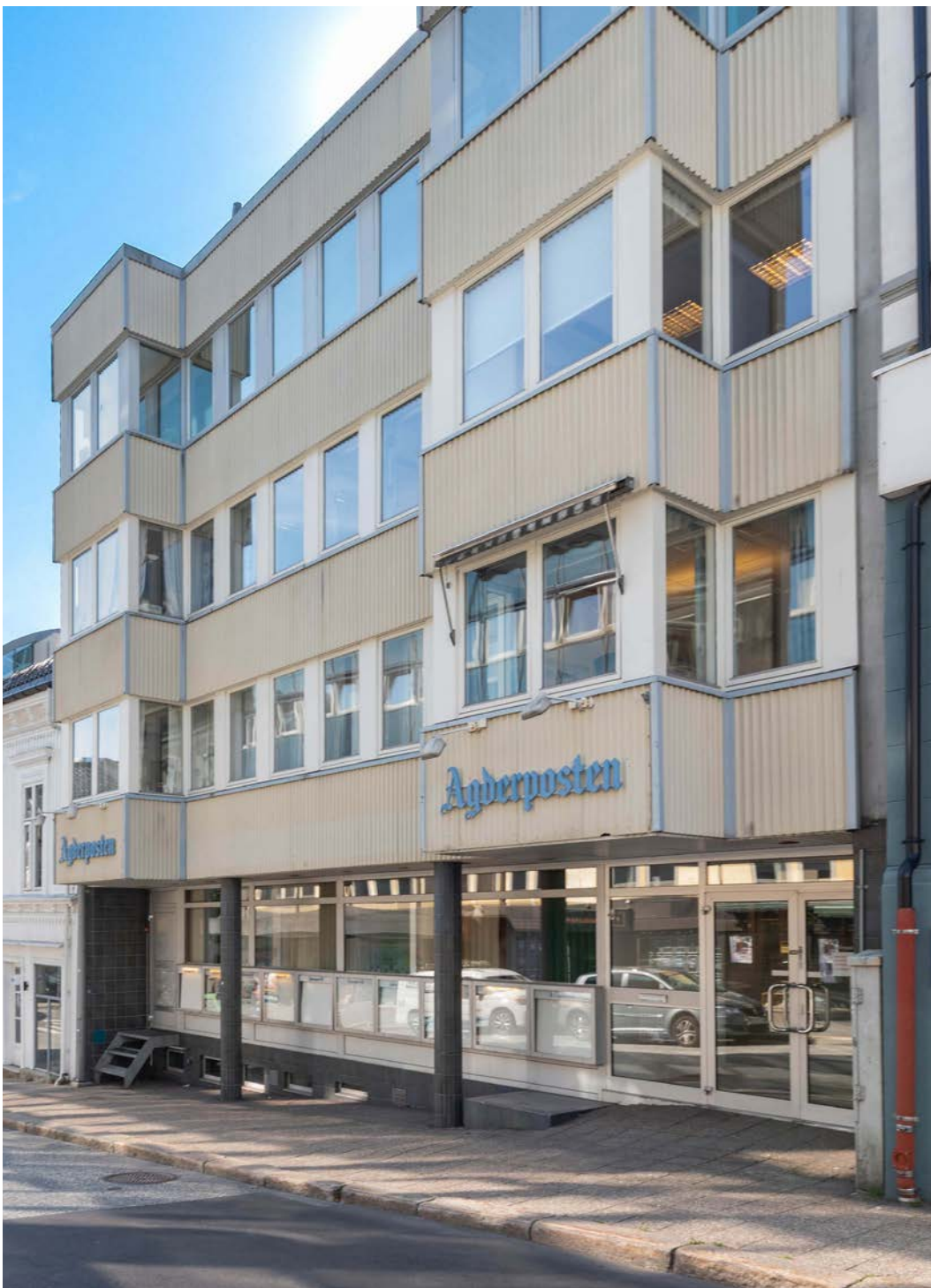
Totalt i underkant av 4500 kvm. med kontor og butikkløkalær.
