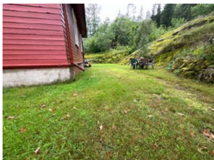
Flatt terreng i bakkant av boligen.
