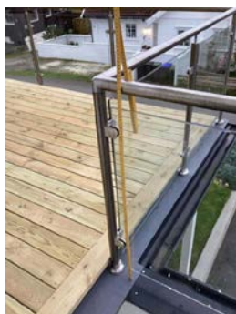
Rekkverk er lavere enn dagens krav
