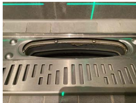
Mansjett påvist under klemring i sluk.
