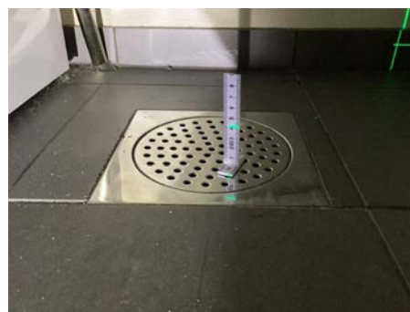
Måling ved sluk
