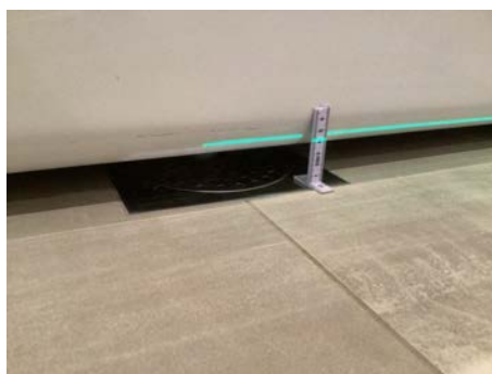
Måling ved sluk under badekar
