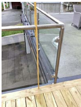
Rekkverk er lavere enn dagens krav
