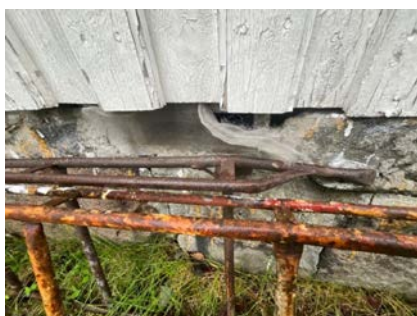
Ventil i mur for ventilering av krypkjeller.
