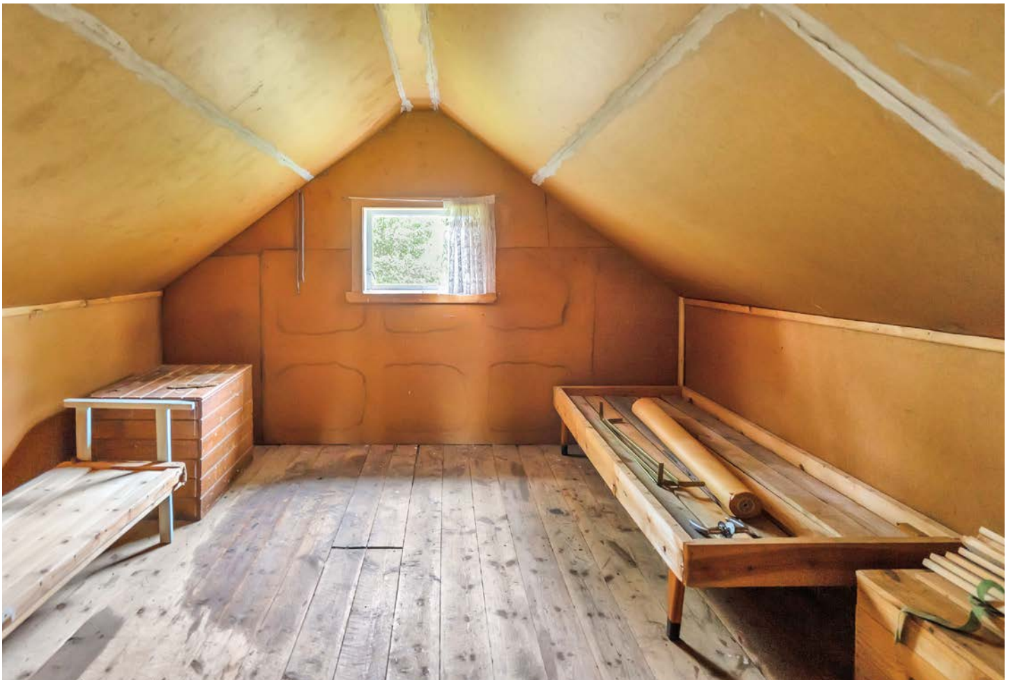
Uinnredet loft og bod.
