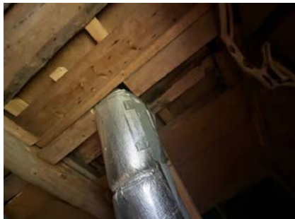
Gjennomføring av lufting i tak.
