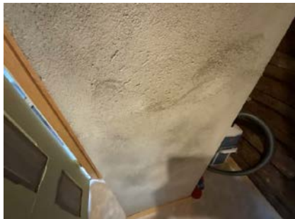
Noe sprekk i murpuss på pipe.
