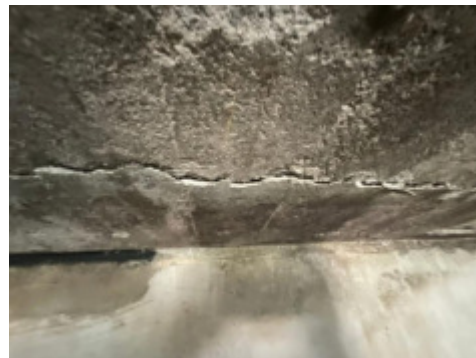
Sprekk i betongdekke
