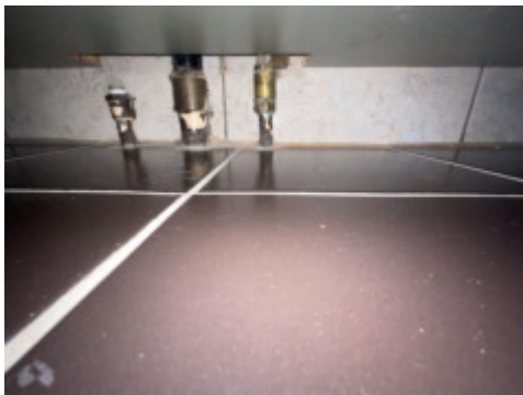
Rørgjennomføring i gulv
