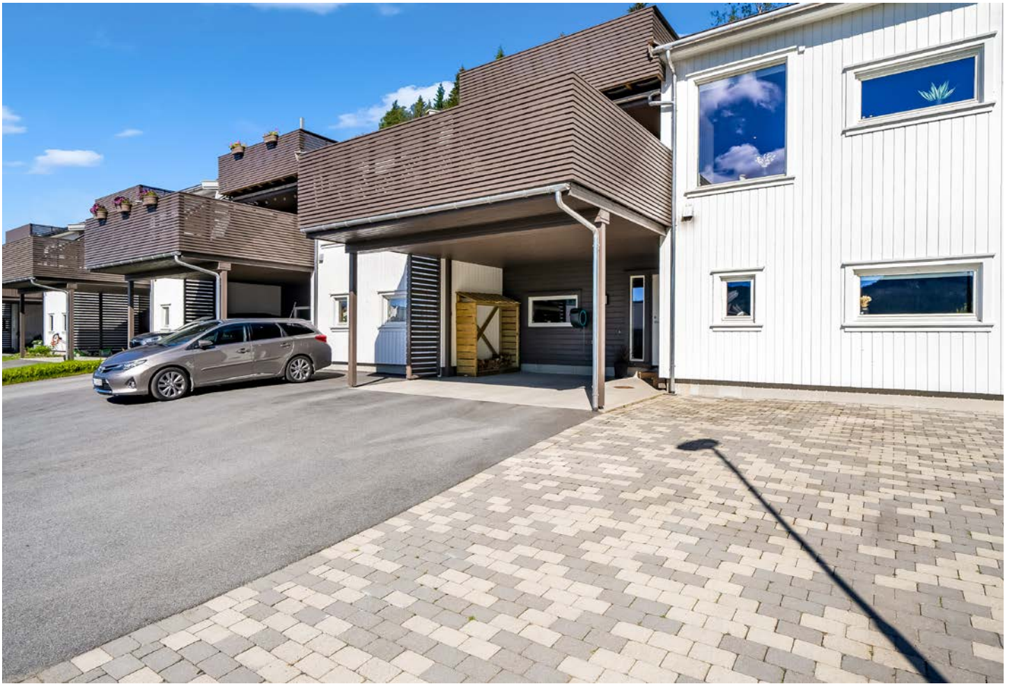
Området i front er asfaltert og steinsatt.
