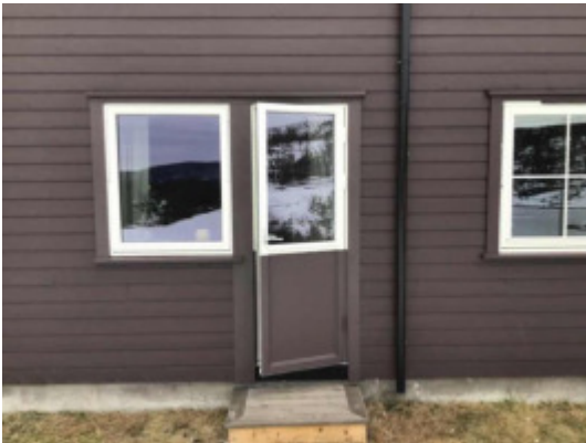
Terrassedør i yttervegg.
