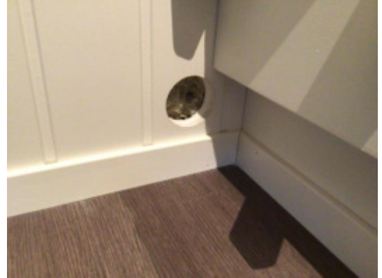
Hull boret i vegg for kontroll av fukt.
