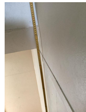
Rekkverk lavere enn dagens krav. Åpning er større enn dagens krav
