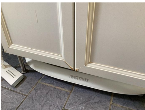
Fuktskader på dører til innredning.
