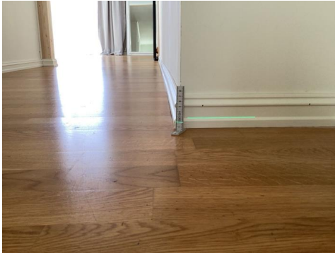
Gang 1 etasje, måling på 2 meter
