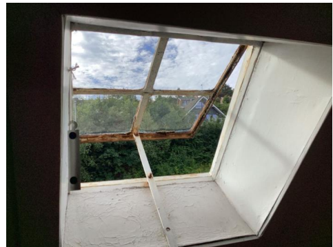
Eldre takvindu i stål på loft
