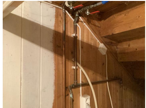
Vannledninger i kobber
