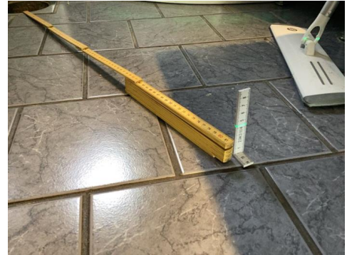
Måling 80 cm fra sluk
