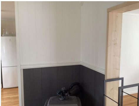
Pipe er kledd inne.
