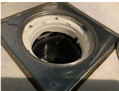
Ukjent løsning på membran i sluk
