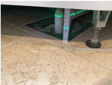
Måling ved sluk
