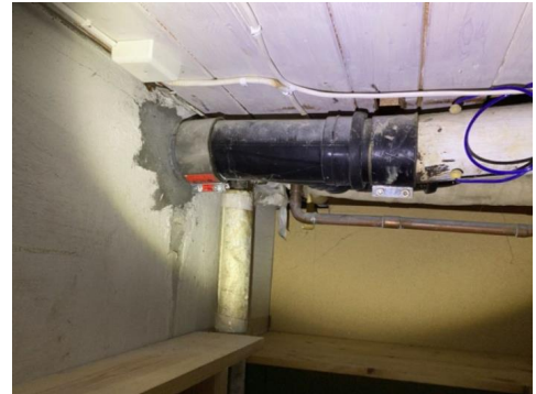
Avløpsrør i plast
