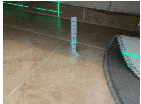
Måling av gulv under innredning.
