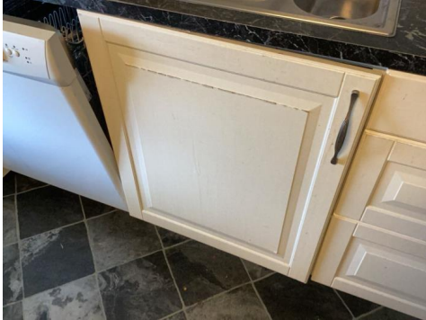
Slitte overflater på fronter
