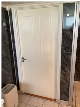
Rommet mangler tilstrekkelig tilluft
