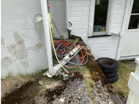
Nedløp fører mot bygg
