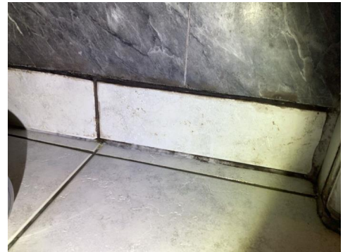
Fliser er limt på utsiden av plater
