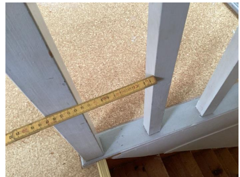
Rekkverk lavere enn dagens krav. Åpning er større enn dagens krav
