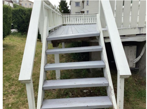
Åpning er større enn dagens krav
