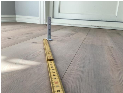
Gang 2 etg måling på to meter
