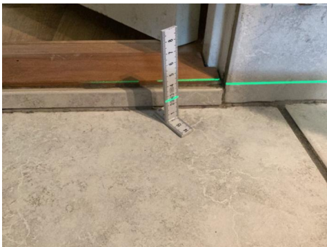
Måling ved terskel KJELLER > BAD/VASKEROM
