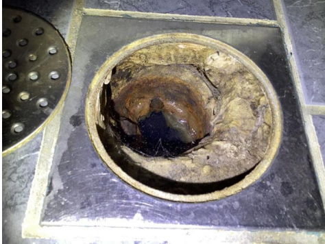
Eldre soillsluk med ukjent membranløsning
