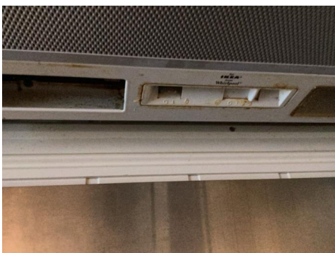
Lysbryter er defekt
