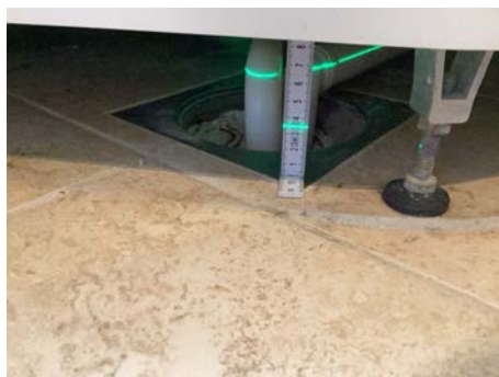
Måling ved sluk
