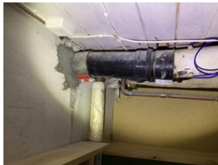
Avløpsrør i plast
