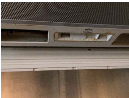
Lysbryter er defekt
