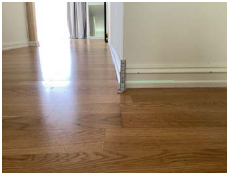
Gang 1 etasje, måling på 2 meter
