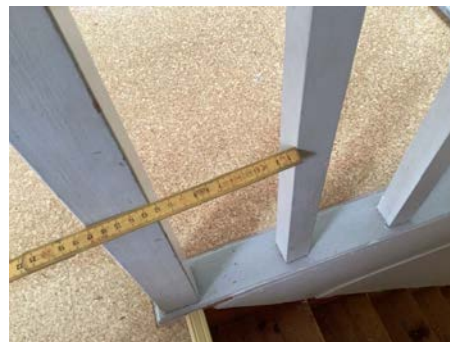
Rekkverk lavere enn dagens krav. Åpning er større enn dagens krav
