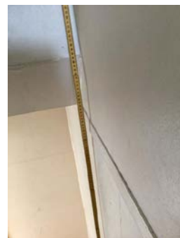
Rekkverk lavere enn dagens krav. Åpning er større enn dagens krav
