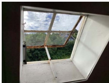
Eldre takvindu i stål på loft
