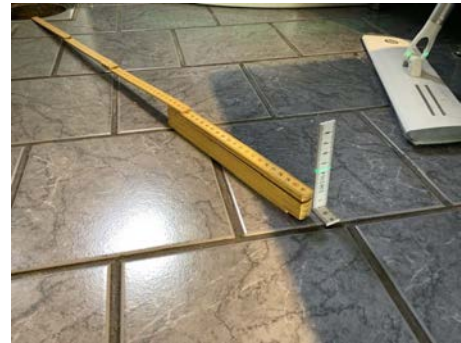
Måling 80 cm fra sluk
