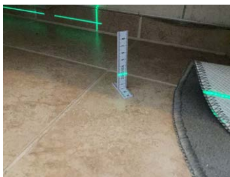
Måling av gulv under innredning.
