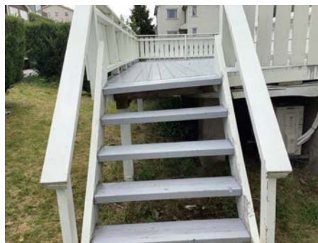
Åpning er større enn dagens krav
