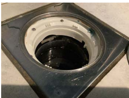
Ukjent løsning på membran i sluk
