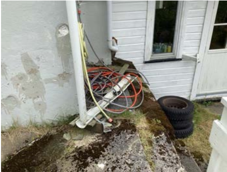
Nedløp fører mot bygg
