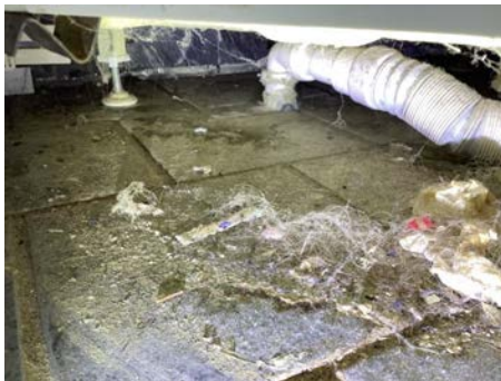
Eldre soilsluk med ukjent membranløsning
