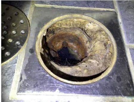
Eldre soilsluk med ukjent membranløsning
