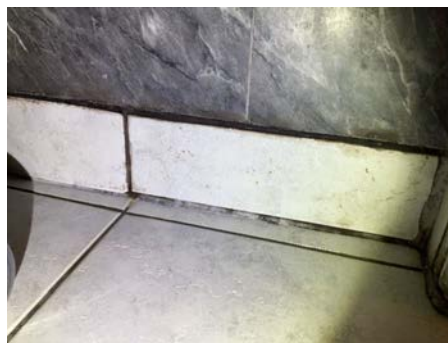
Fliser er limt på utsiden av plater
