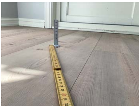
Gang 2 etg måling på to meter
