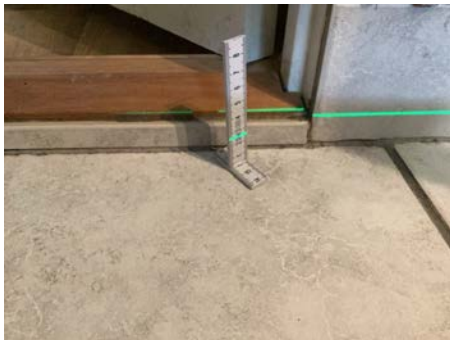
Måling ved terskel KJELLER > BAD/VASKEROM
