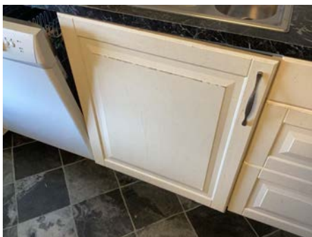
Slitte overflater på fronter
