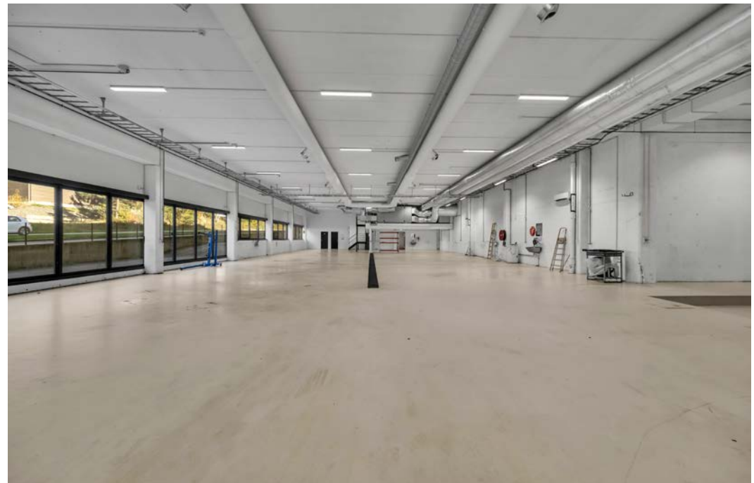
1 etasje med slukrist, mesanin med hovedtavle og ventilasjon for etasjen
