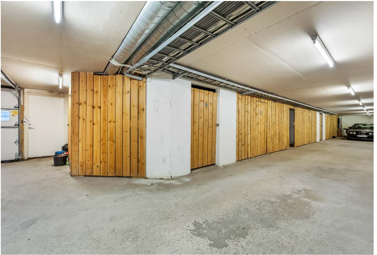
Bod i garasjen.
