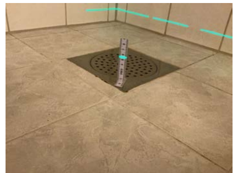
Måling ved sluk
