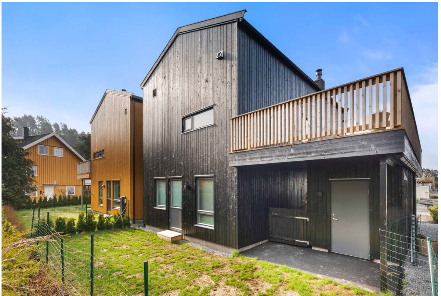
Inn gjæret hage/plen på baksiden av boligen. Adkomst til boden i bakkant av car-porten.
