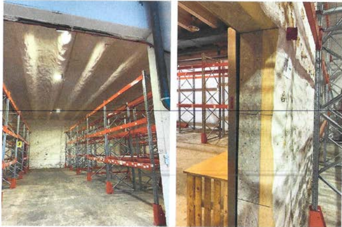
Lager del som tidligere ble brukt som fryseler. Himling og vegger er sprøyteisolert med isolasjons skum.
