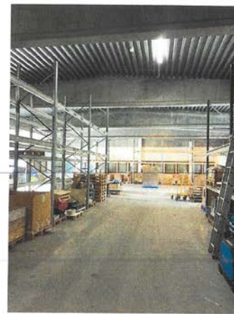
Lager hall i bygg fra 1979 – 1981.
