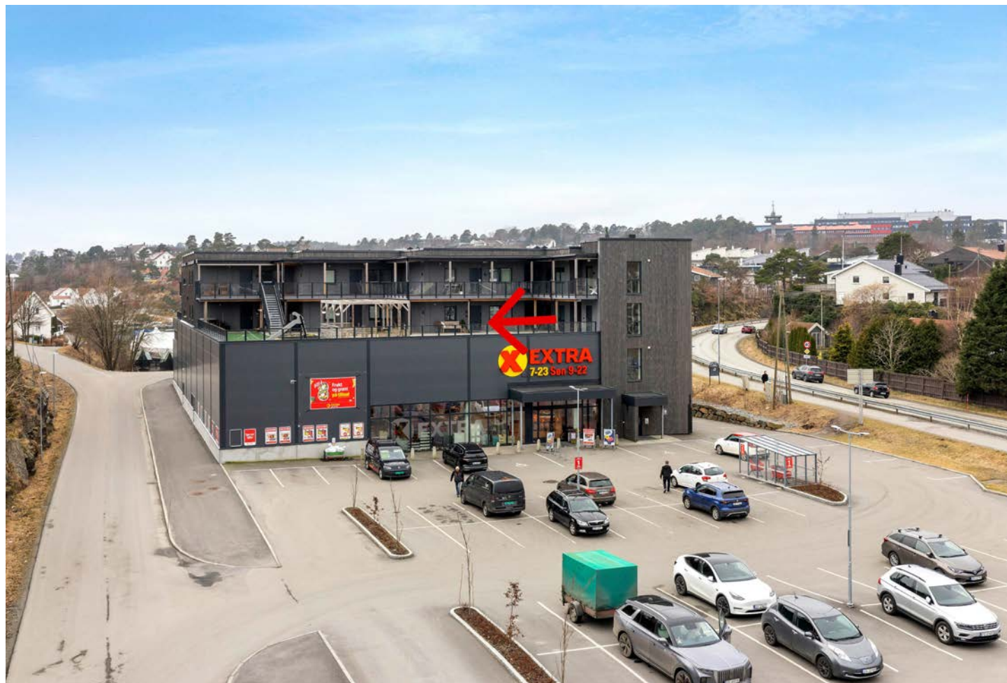
Enkel adkomst til Coop Extra som er i samme bygg.
