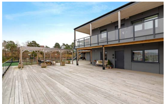
Adkomst til leilighet via felles takterrasse.
