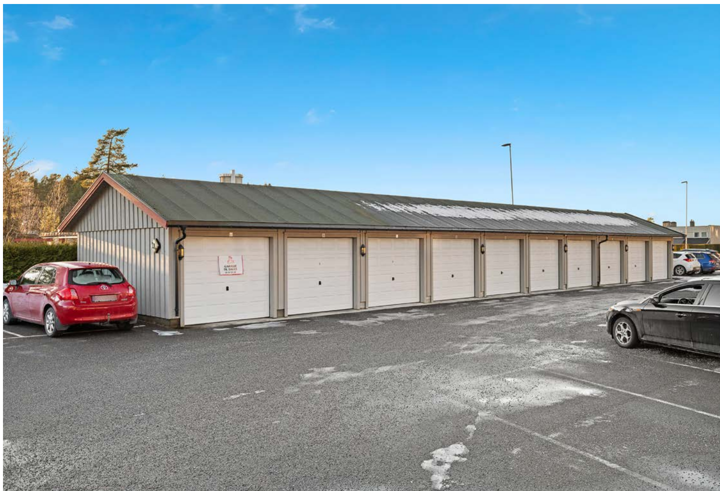
Borettslaget har godt med parkeringsplass - og det er etablert elbillading
