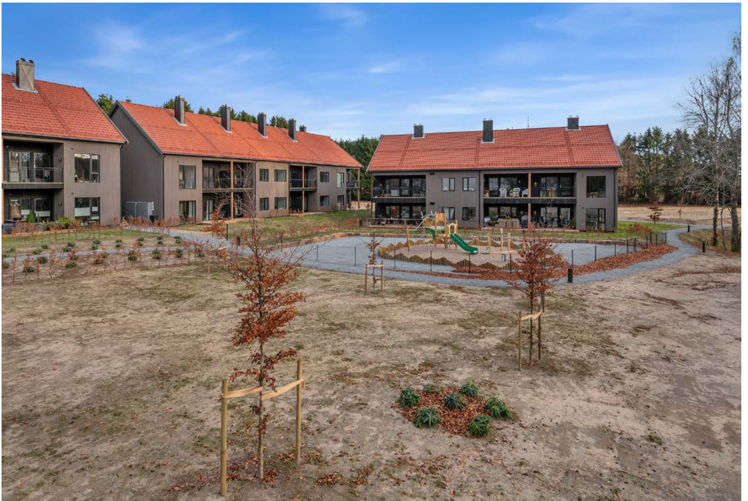
Pent opparbeidet uteområde
