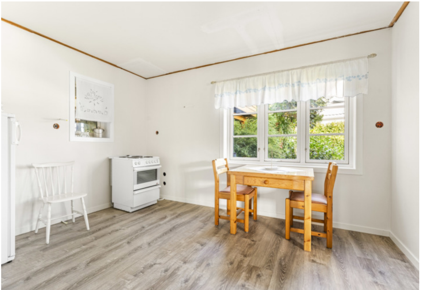
Kjøkkenrom der kjøkkenet er fjernet, det er lagt opp rør opplegg og strøm til nytt kjøkken
